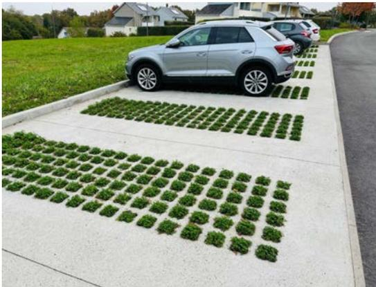
Assure l'infiltration des eaux pluviales de 90L/min/m<sup>2</sup> pour la version engazonnée et 240L/min/m<sup>2</sup> pour la version gravillons.
