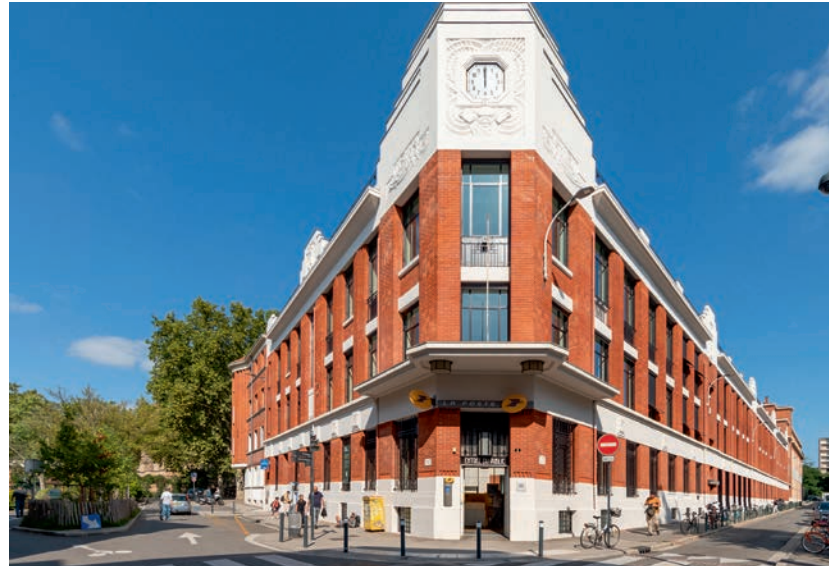
Le village de services La Poste Saint-Aubin : une intervention qui magnifie le patrimoine architectural.
