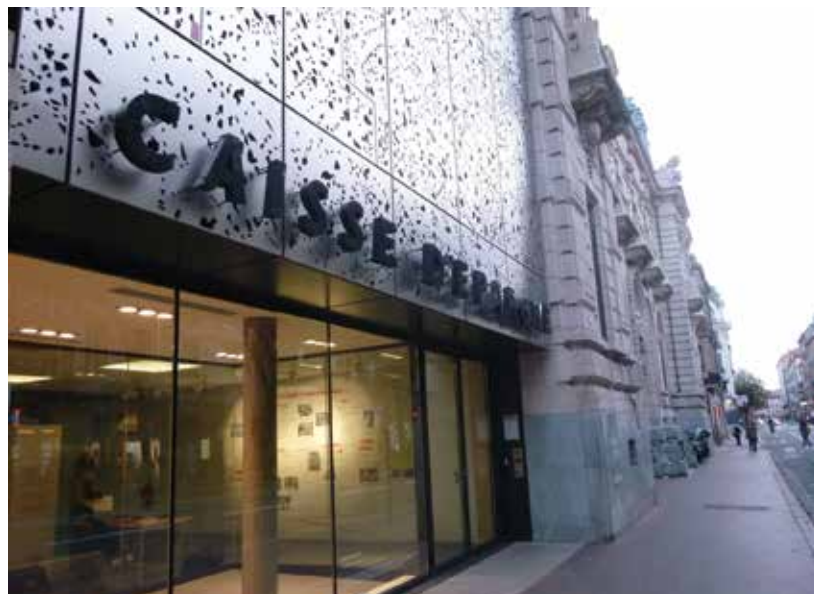
La rénovation du siège historique de la Caisse d'épargne de Midi-Pyrénées (MO: Caisse d'épargne de Midi-Pyrénées; MOE: Taillandier Architectes): le parti de la maîtrise d'ouvrage a été de signer la contribution de la banque au patrimoine urbain et au développement territorial. Au risque de se voir reprocher par des clients une architecture trop contemporaine...
