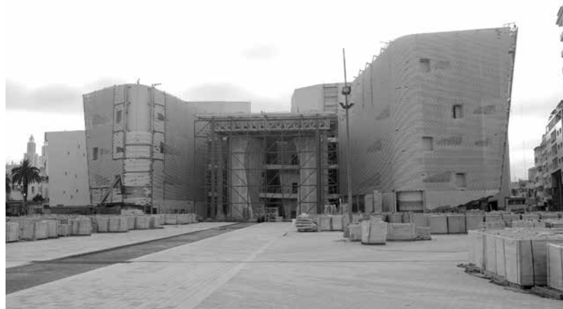
Les grands aménagements portés par l'AUC: le nouveau quartier d'Anfa (page de gauche haut), CasArts (page de gauche bas), l'École centrale (page de droite, gauche), Casa Marina autour de la grande mosquée Hassan II.
