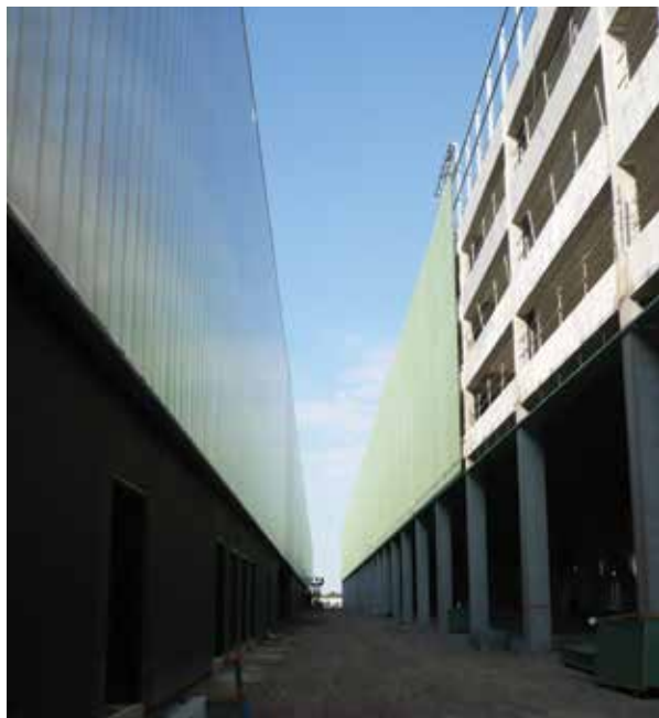
Haut: le grand hall et sa remarquable charpente métallique; bas: la rue intérieure, structurant l'ensemble du site.
