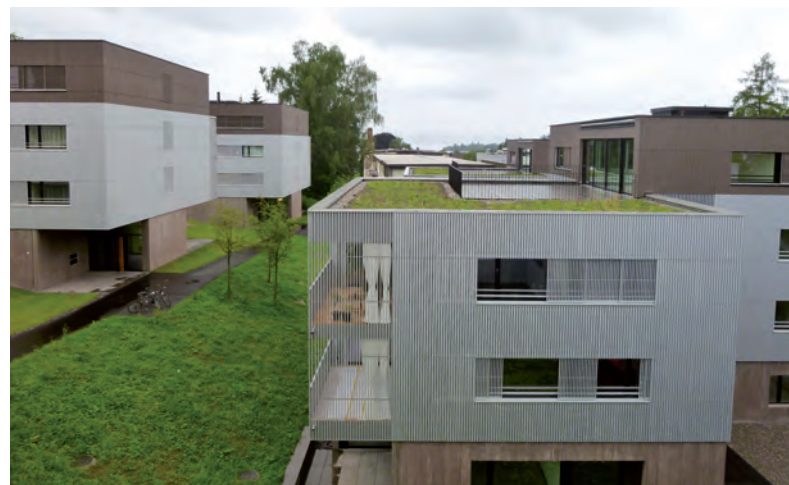
Résidence Fluh (Burkhalter/Sumi) : une composition à 3 niveaux, rythmée régulièrement par une assise en béton et métal (r-d-c + niveau 1) et un troisième niveau, de facture bois, dont le volume décroche élégamment sur l'arrière du bâti.
